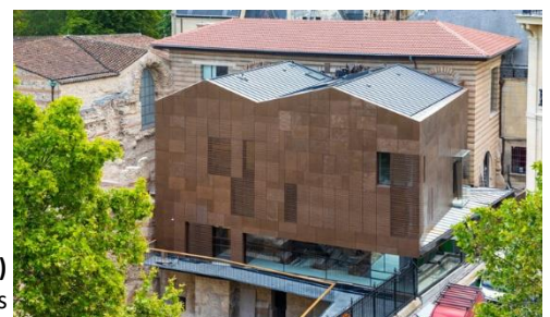
Bernard Desmoulin (né en 1953) Rénovation et extension du musée de Cluny, 2022, Paris
