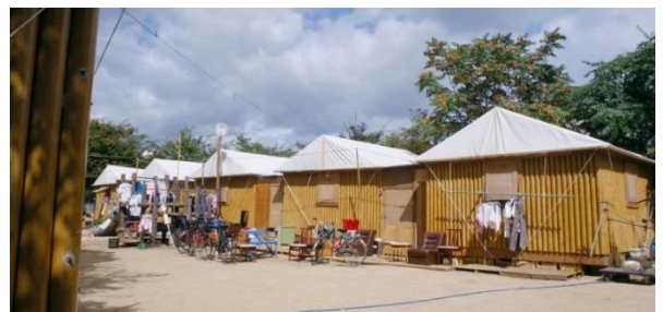
Shigeru Ban (né en 1957) Paper Log House, 1995 Fondations constituées de caisses de bière remplies de sable, murs en tubes de papier et toit et plafond constitués de membranes de tente
