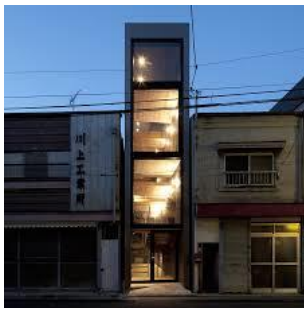
Studio YUUA Maison de 1,8 m de largeur, 2012 Photographie © Goro Mizukami Tokyo, Japon
